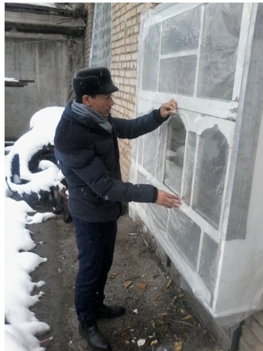
1-расм. Ойнали ромни ташқи девор сиртига ўрнатилиши.
