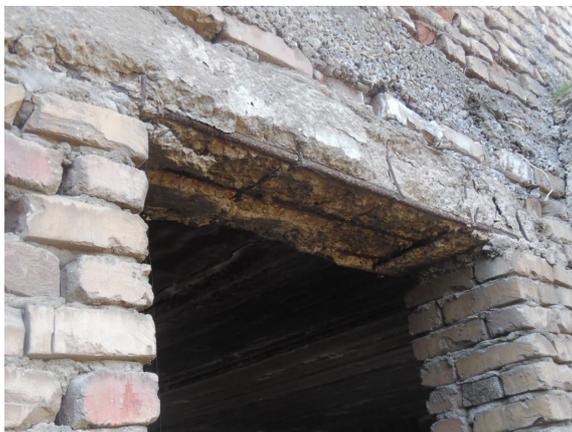
Рисунок 2. Разрушение защитного слоя бетона в железобетонной перемычке.
