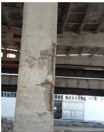
Рисунок 3. Разрушение защитного слоя бетона вдоль усадочных трещин.
