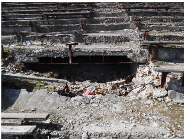
Рисунок 4. Разрушение бетона вызванное многократным замораживанием и оттаиванием увлажненного бетона.
