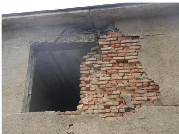
**Рисунок 7.** Повреждения кирпичной кладки в стене здания специализированного (многопрофильного) государственного дошкольно-образовательного учреждения №8 Булунгурского района Самаркандской области.
