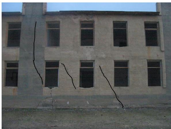
**Рисунок 1.** Наклонные трещины в кирпичной стене здания школы №113 в кишлаке Багишамал Пастдаргомского тумана Самаркандского вилоята.
