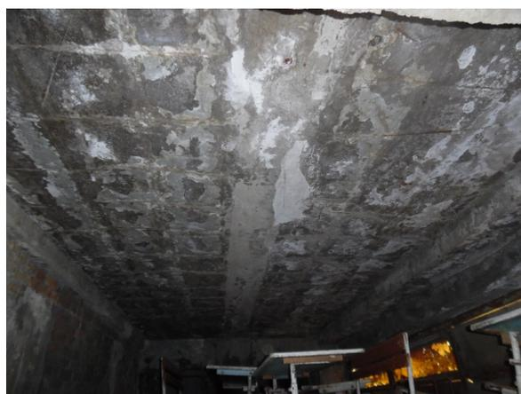
Рисунок 5. Коррозия бетона железобетонных плит покрытия здания школы № 16 в городе Самарканде.
