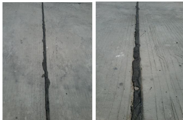
3-расм. Иссиқ об-ҳавода сиқилиш чокларидаги мастиканинг қоплама юзасига чиқиб қолиши
