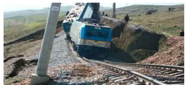
Рис 5 Ливневые дожди приводящие к оползням. Оползень, приводящий к крушению железнодорожного состава.
