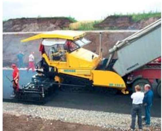
5 – расм. Асфальтётқизгич билан қоплама қуриш
