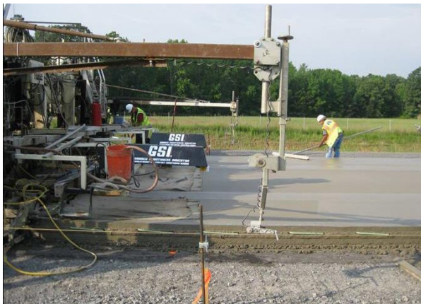
5-расм. “GOMACO GSI” Цементётқизгичга ўрнатилган реал вақтда профилни ўлчаш қурилмаси [6]
