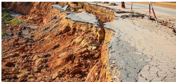
Рисунок 6. Оползень после ливневых селей в автомобильных дорогах, где недалеко от них проходит железная дорога.
