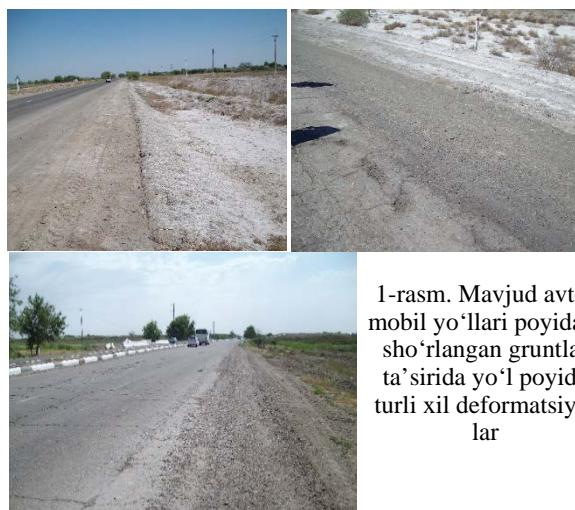
1-rasm. Mayjud avtomobil yo'llari poyidagi sho'rangan gruntlar ta'sirida yo'l poyida turli xil deformatsiyalar
