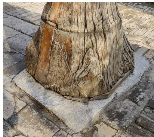
Рисунок 3. Конструктивная особенность устройства деревянных колонн заключалась в устройстве гранитных камней под ними (для защиты от грунтовой влаги)
