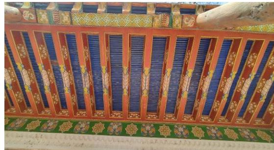
Рисунок 2. Вид деревянного потолка, деревянных колонн, стены из обожженного кирпича, карниза из ганча махаллинской мечети по улице «Бибихоним»
