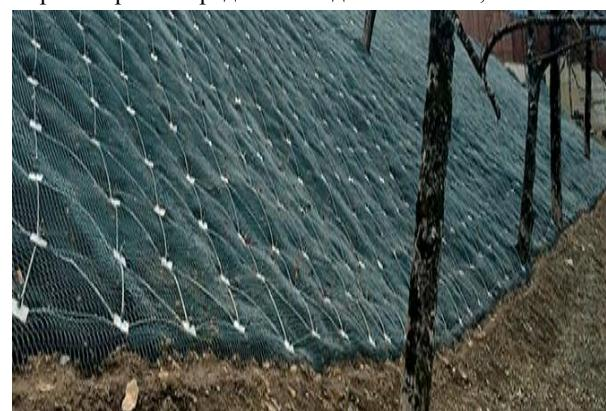
6- рисунок. Защитные инженерные сооружения, защищающие транспортные пути от оползней и падения камней на склонах гор.
