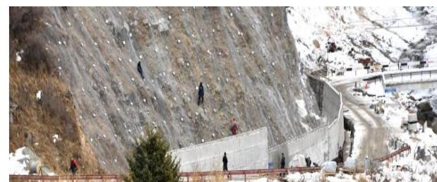
Рис. 5. Укладка металлобетонной стены для защиты транспортных средств от падения камней, оползней
