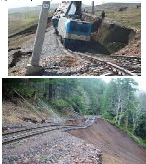
Рисунок 4. Разрушения, которые приносят оползни.
