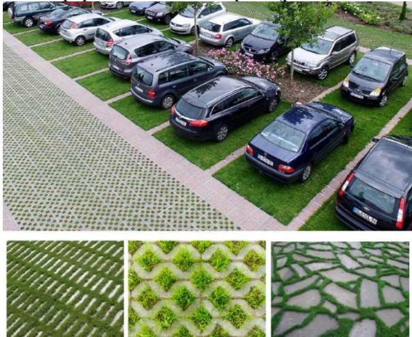
Рисунок 5 Пример обустройства экопарковки, которая свободно впитывает дождовую воду
